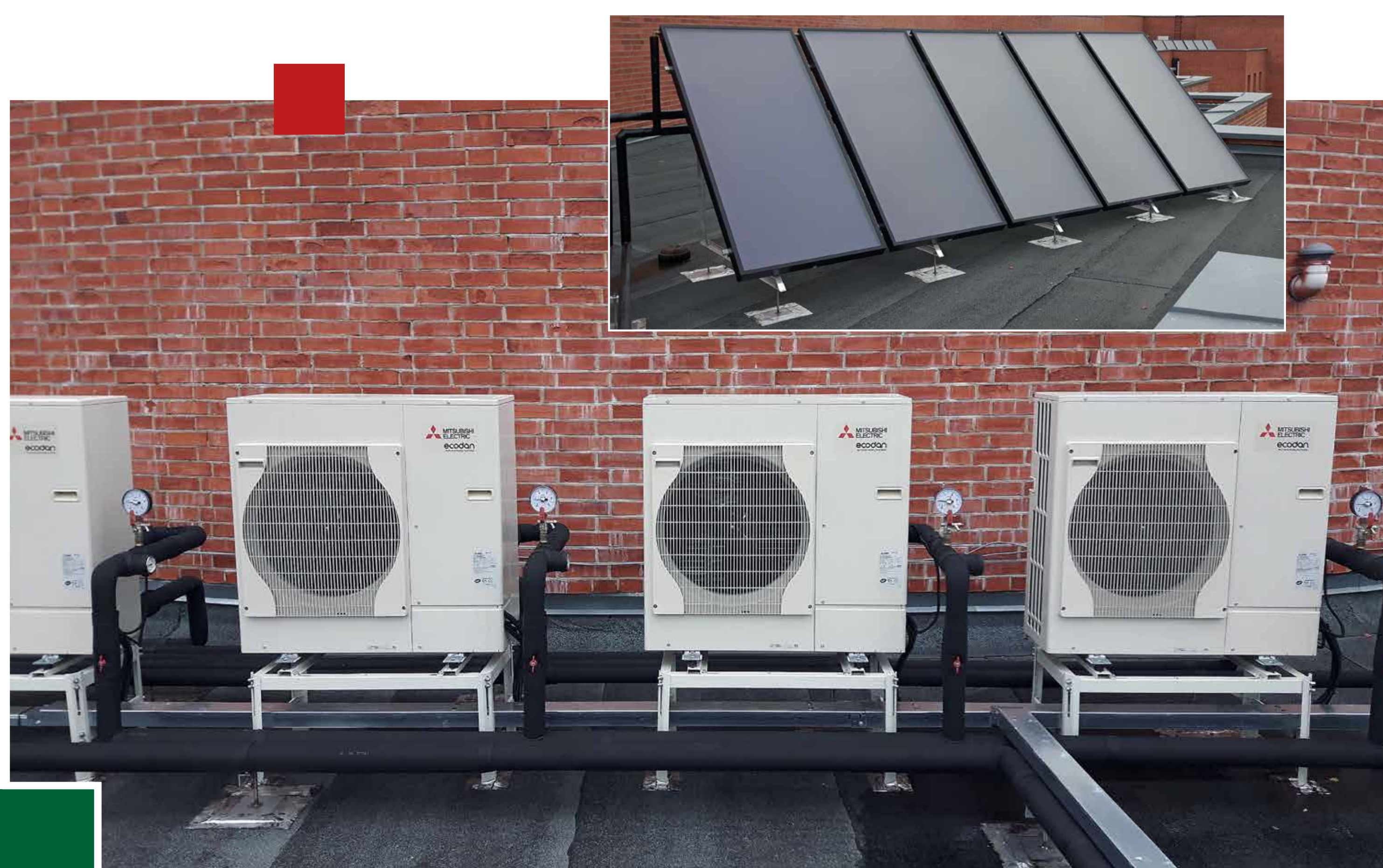
Saulės kolektoriu ir šilumos siurbliu sistema
